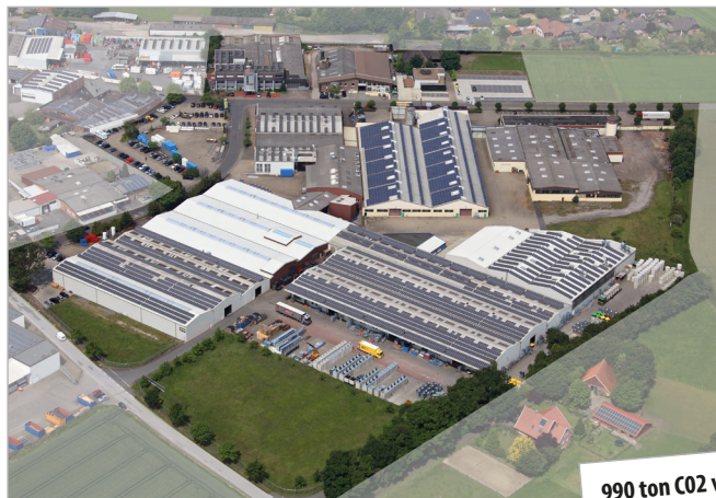
Fabriek I en kantoren Südlohn
